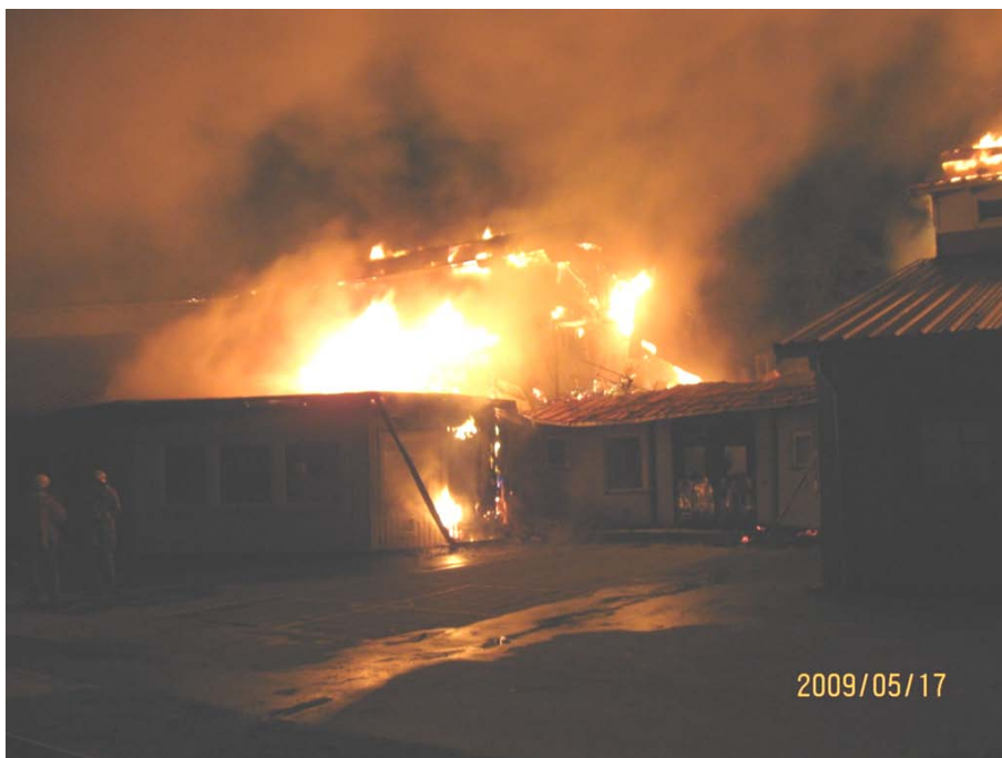
Figur B 19. Bilden tagit vid klockan 01.30. Man ser redan att det primära området har brunnit ordentligt och att en del av väggen/taket har rasat i hörnet. (ljusinställningar har ändrats) Bilden är tagen från polisen.
