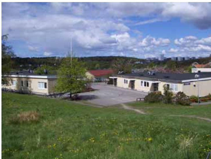
Figur 65 Exempel på envånings träbyggnad med platt tak byggd 1985.
