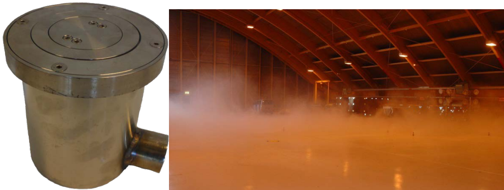
Figur 18 Munstycke för dämpning och släckning av spillbränder i flygplanshangarer. Foton publicerade med benäget tillstånd av VID Fire-Kill ApS.
