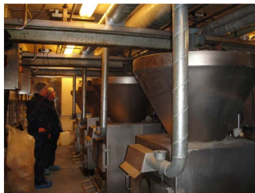
Figur 35 Placering av munstycke ovanför en av rökgeneratorerna som används för att smaksätta korv. Foton publicerade med benäget tillstånd av Novenco Fire Fighting AS.
