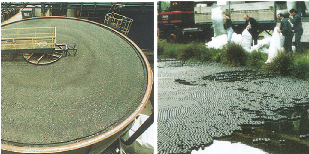
Figur 1 Plastbollar är ett vanligt sätt att reducera avdunstning, lukt, värmeförluster från vätskeytor [3].
