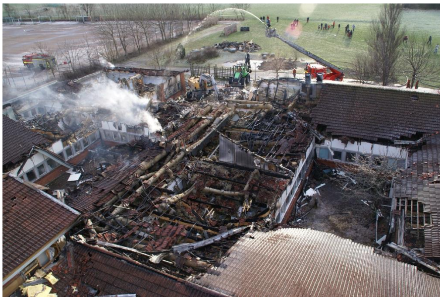
Bild 1: Omfattande brand till följd av en anlagd brand (Foto: Stefan Svensson).
