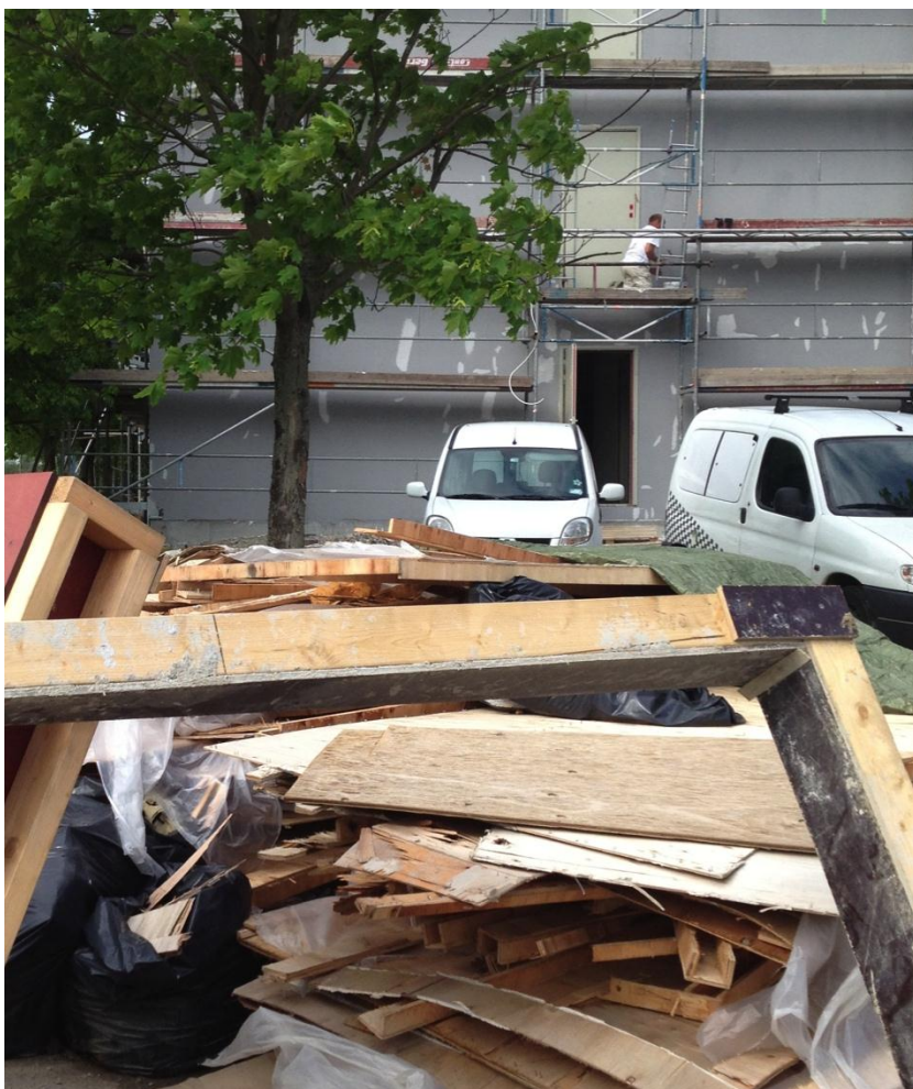
Bild 10: Under byggtiden är det viktigt att brännbart material läggs undan och ej lagras nära bygget.
