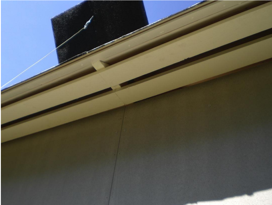
Bild 6: Glespanel i luftad takfot.
