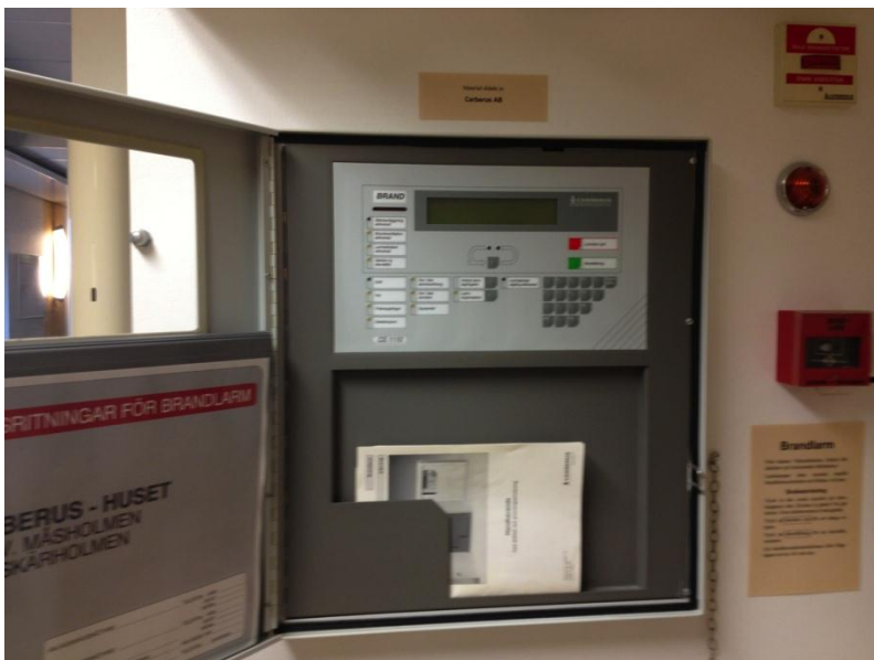
Bild 4: Centralapparat och brandförsvarstablå.
