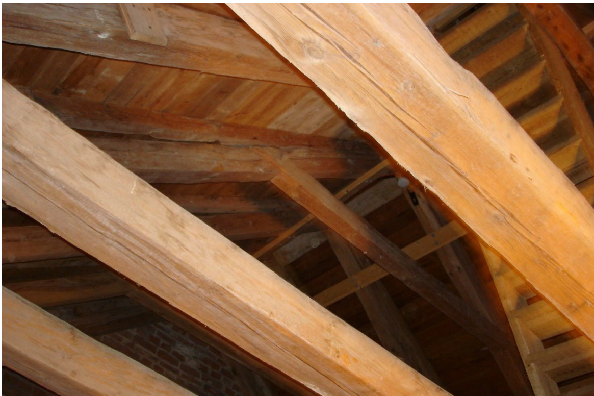
Bild 9: Vindsutrymmen i större kulturhistoriskt värdefulla byggnader innebär stora utmaningar avseende placering och val av sprinkler. Foto: Magnus Arvidson, RISE.
