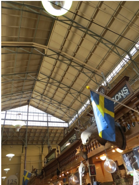
Bild 1 Tidiga stålkonstruktioner i Östermalms Saluhall, Stockholm.
