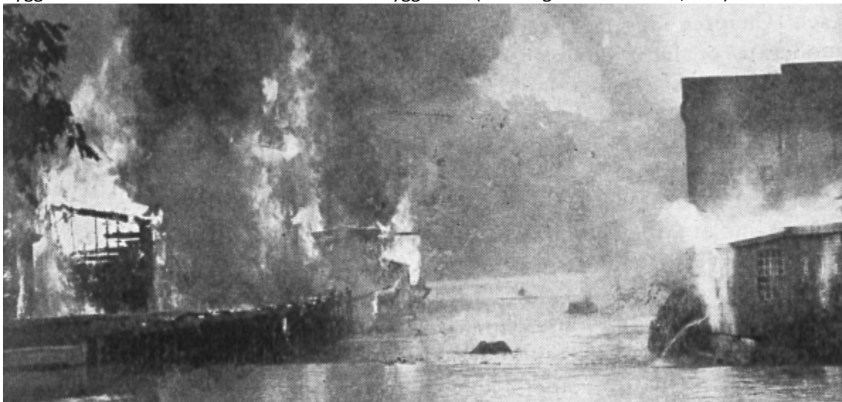
Bild 1 Brandspridning genom överföring av värmestrålning. Vinden låg vid tillfället på från höger till vänster i bilden. Trots detta antände byggnaden till vänster om floden, genom värmestrålning, byggnaden på höger sida. Bilden är från Wellesley, Massachusetts, USA, 1946 (Crosby et al., 1954).
