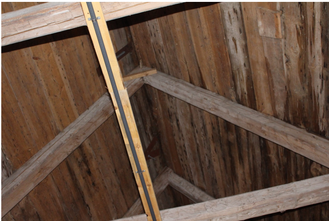
Bild 2: Förläggning av samplingsrör för ett aspirerande branddetektionssystem i ett vindsutrymme. Foto: Magnus Arvidson, RISE.
