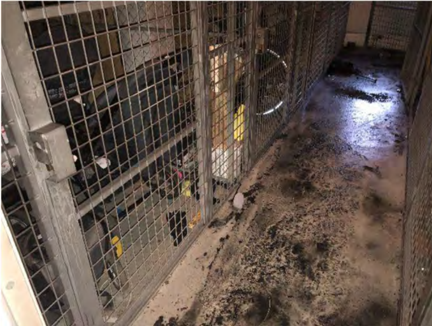
Figur B.13 – Brand i förråd, Källa: RSG
