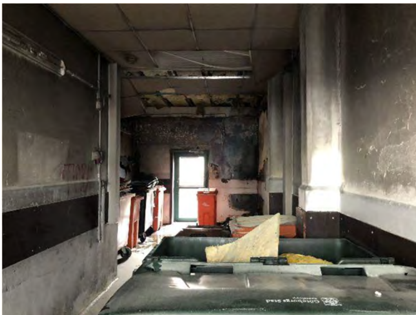
Figur B.6 – Inifrån soprum, Källa: RSG
