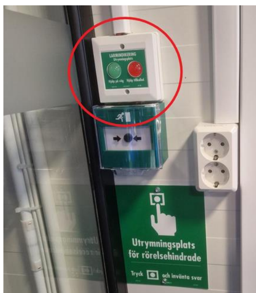
Figur 5.12 Exempel på utrymningsplats försedd med signallampa
