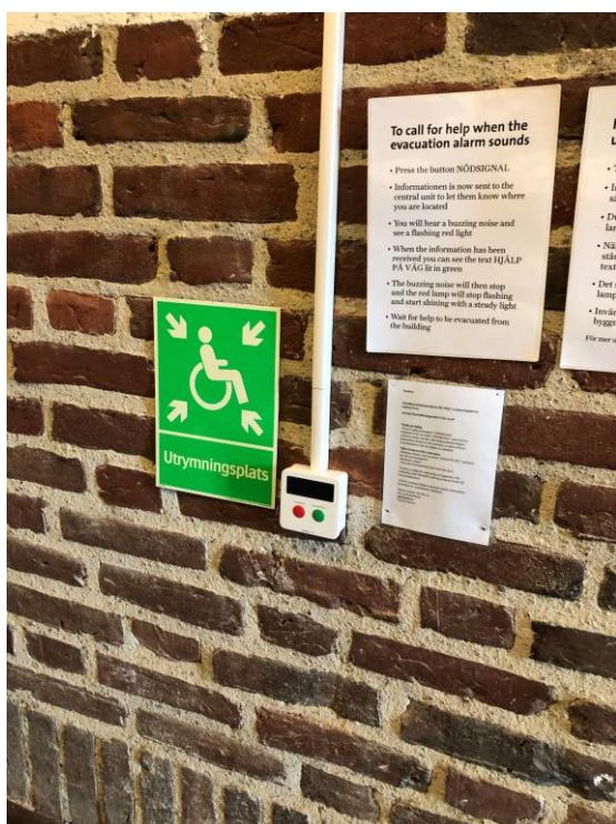
Figur 4.11 – utrymningsplats placerad i en utrymningstrappa
