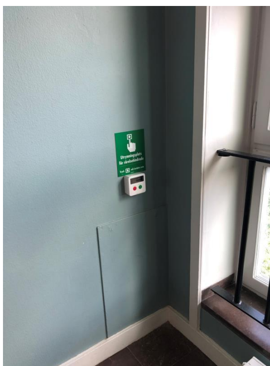
Figur 4.12 – utrymningsplats placerad i en utrymningstrappa
