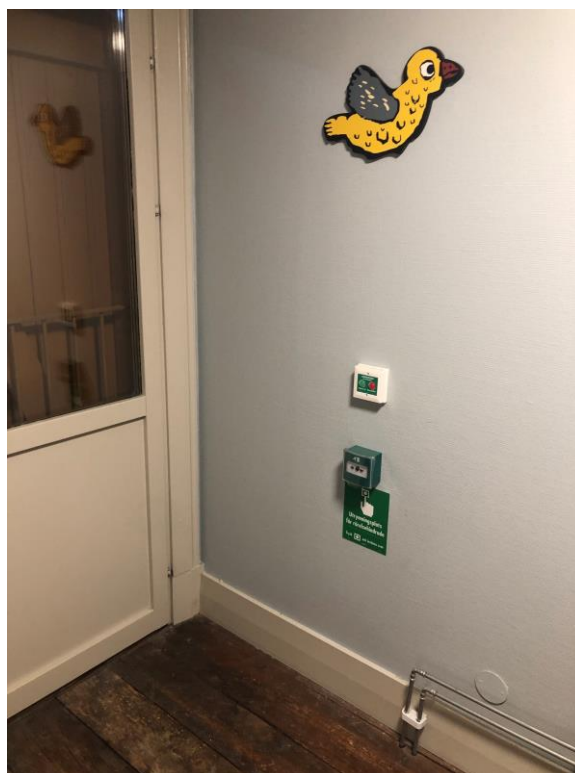
Figur 4.8 – utrymningsplats placerad i en utrymningstrappa
