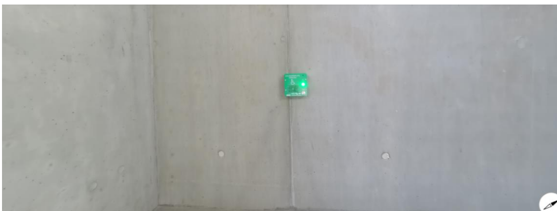
Figur 6.7 – Fokusering på utformningen av tvåvägskommunikationen tillhörande utrymningsplats 2.
