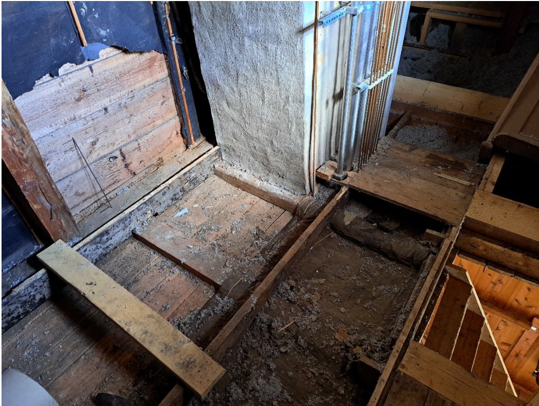
Figur 8 Foto från platsbesöket i september 2023, veckan efter aktiveringen. Den våta lösisoleringen var avlägsnad. Foto: Magnus Arvidson, RISE.
