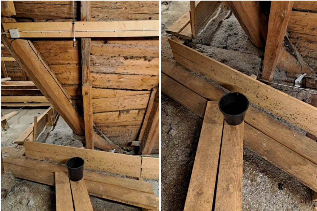
Figur 43 Hink under ett högtrycksmunstycke som läcker frysskyddsmedel. Foto: Magnus Arvidson, RISE.
