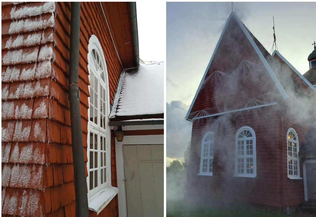
Figur 9 Vid en stöld av i första hand stuprör och åskledare av koppar aktiverade en utvärdig sektion med munstycken (högtryckssystem) när tjuvarna också försökte stjäla värmedetektkabel. Händelsen inträffade vintertid vilket orsakade isbildning på fasaden. Foto: Dave Clarke, Svenska kyrkan. Till höger ses provning av samma sektion vid platsbesöket hösten 2023. Foto: Magnus Arvidson, RISE.
