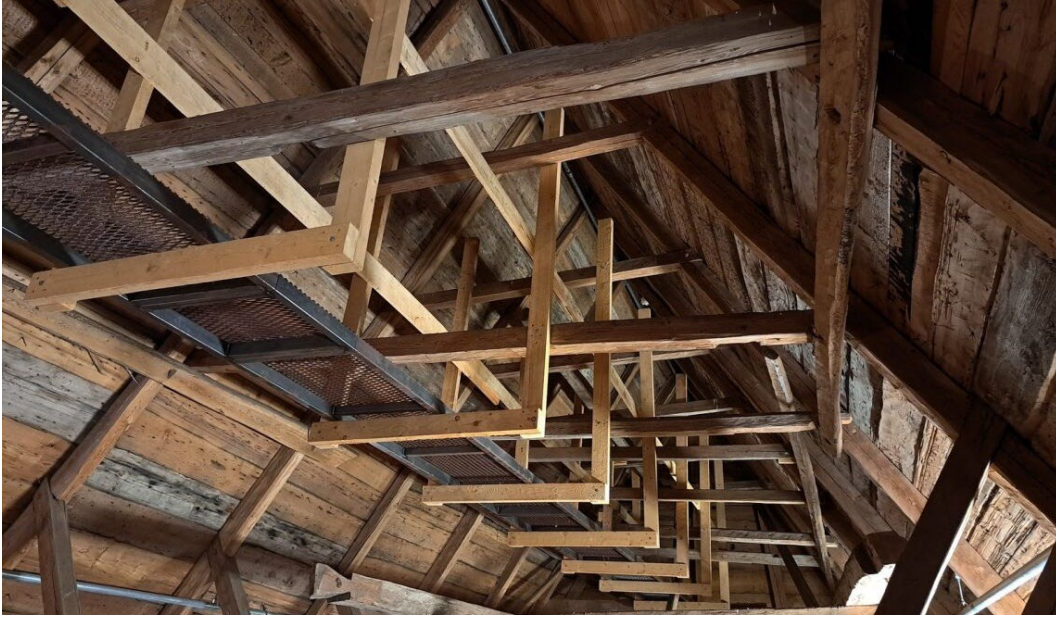
Figur 21 Exempel på gångbrygga under taknocken som är tillverkad av obrännbar gallerduk som är vattengenomsläpplig. Foto: Magnus Arvidson, RISE.
