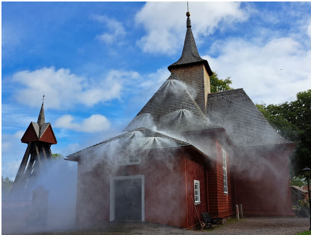
Figur 3 Aktivering av ett högtryckssystem med öppna munstycken som vattenbegjuter kyrkans spåntak. Dagen när provet genomfördes var blåsigt. Foto: Magnus Arvidson, RISE.
