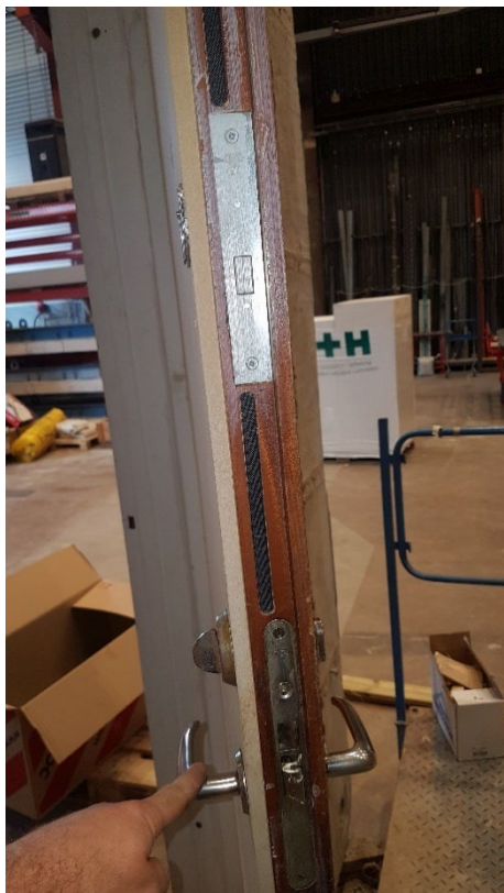
Figur 14. Dörr kompletterad med MDF-skiva och brandsvällande list infräst i dörrbladet.
