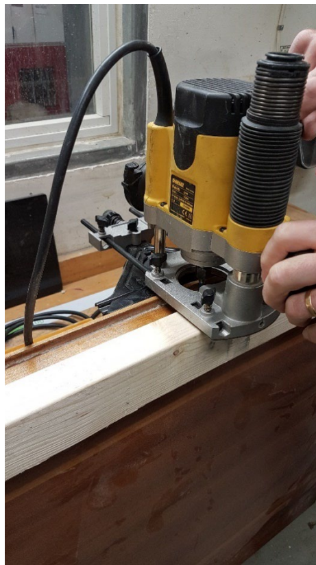
Figur 15. Fräsning innan montering av brandsvällande list
