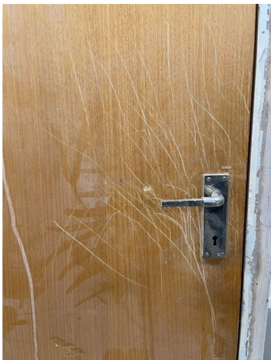
Figur 20 Dörr med rivskador från husdjur
