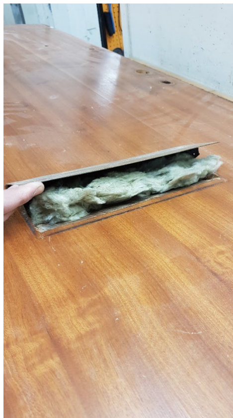
Figur 17. Brevinkast fyllt med stenull.
