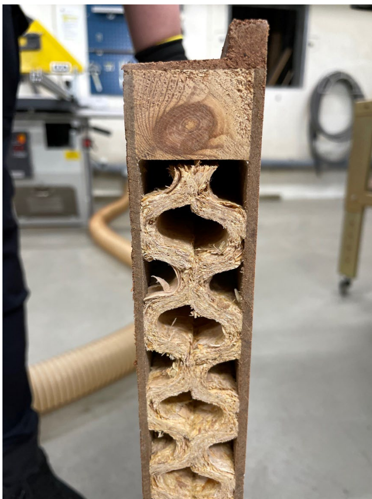
Figur 4: Innanmätet av dörrtyp B från ca 1959. Hela dörrens djup uppgår till 4,5 cm.
