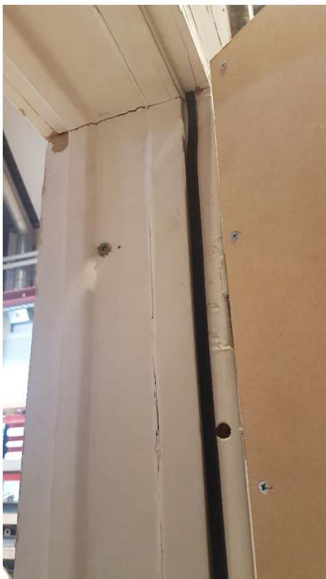
Figur 16. Tätning (svart) monterad i dörrkarm samt skruvad MDF-skiva med 20 cm mellan skruvarna.
