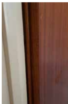
Figur 2, Äldre brandtekniskt oklassad lägenhetsdörr, i teaklaminat med brevinkast.
