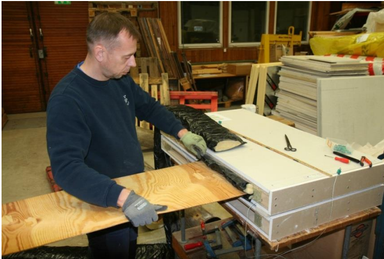
Figur 20. Insättning av U-format brandstopp i hålrum med installationshjälp
